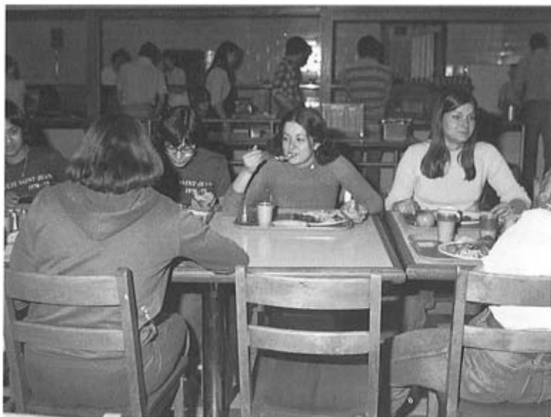
L'ancienne cafétéria en opération
